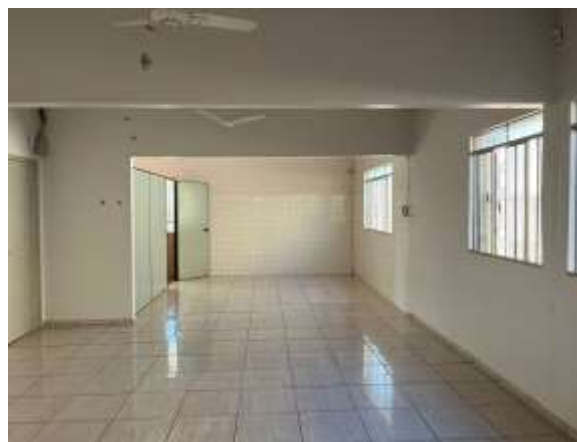
OBRA EM ANDAMENTO
